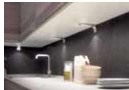
Corpuri de iluminat montate sub corp suspendat
